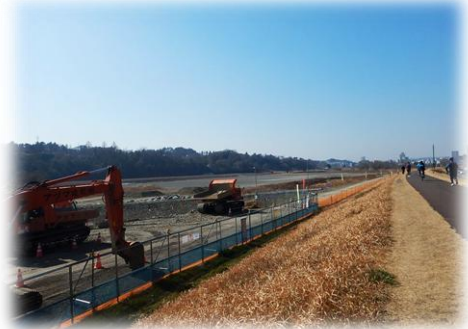
治水対策として河床の掘削などの工事が行われていた博物館地先の多摩川 (2026年2月)。
