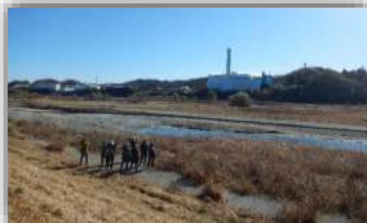
大丸用水堰の改築工事が進む府中地先の多摩川(2024.12月撮影)
